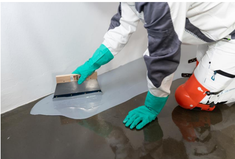
1397 – 2 Auftrag Beschichtung per Hand.jpg
